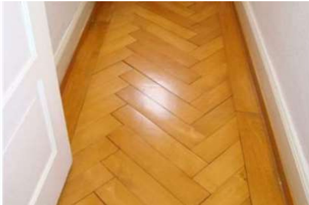
Zweibruggenmühle 11, 9014 St. Gallen
