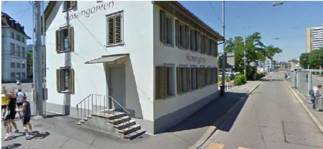
Ehem. Rest. Rosengarten, Kalkbreitestr. 2, 8003 Zürich
